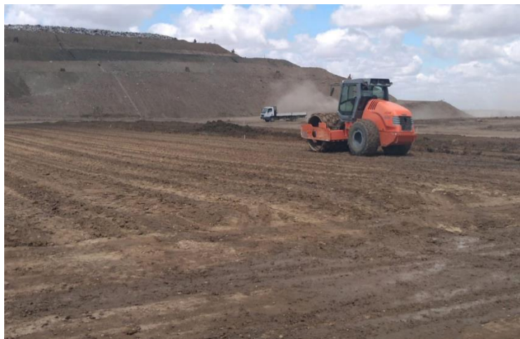
Figura 11 – Construção de uma das células do Aterro Sanitário de Campina Grande.
