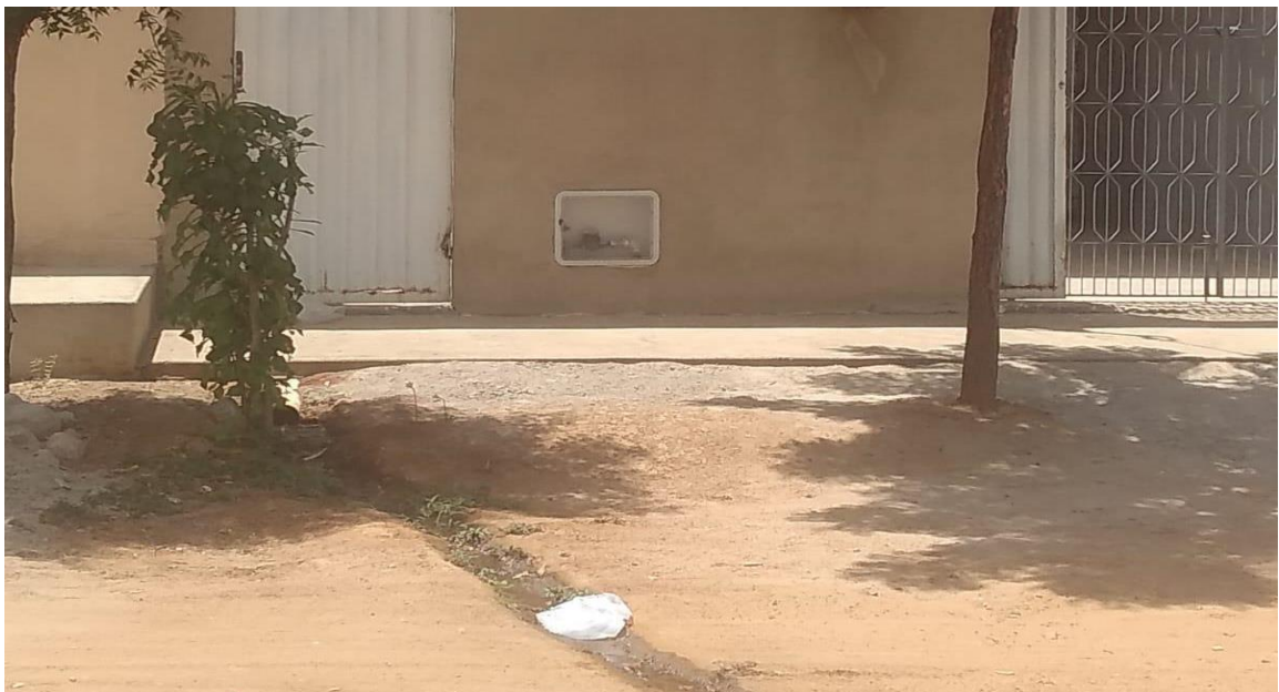
Figura 13 - Águas cinzas sendo lançadas na própria rua, na frente do imóvel
