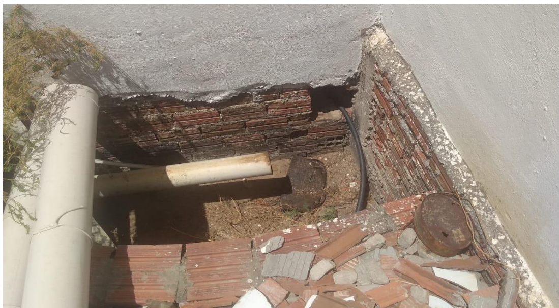
Figura 20 - Construção de fossa séptica auxiliar nos fundos de imóvel recém construído.
