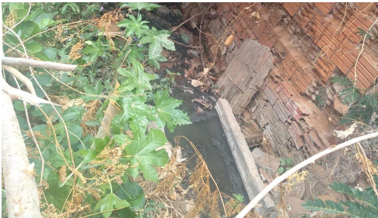
Figura 3- Esgoto sem nenhum tipo de tratamento sendo lançado no rio Poti.
