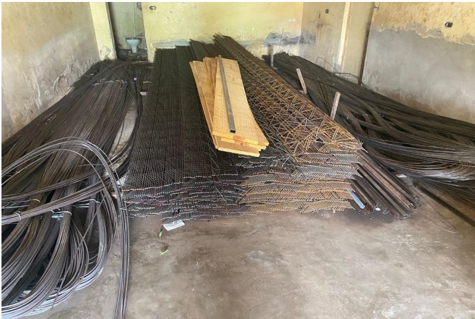
Figura 9 – Armazenamento de aço na loja B
