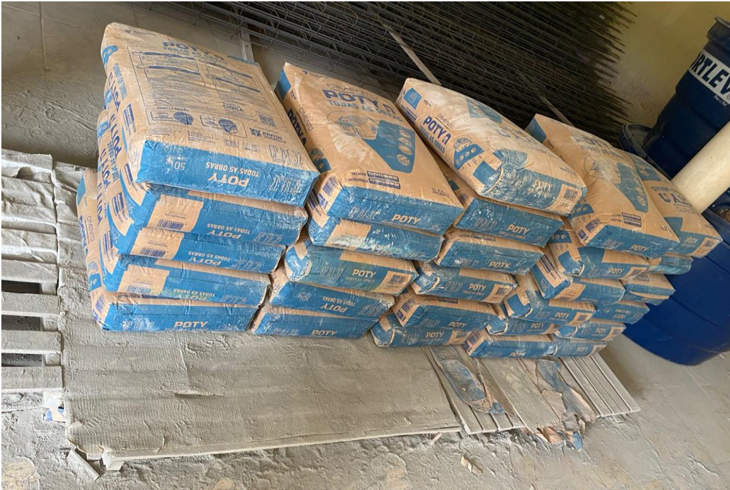
Figura 4 – Armazenamento do cimento na loja A
