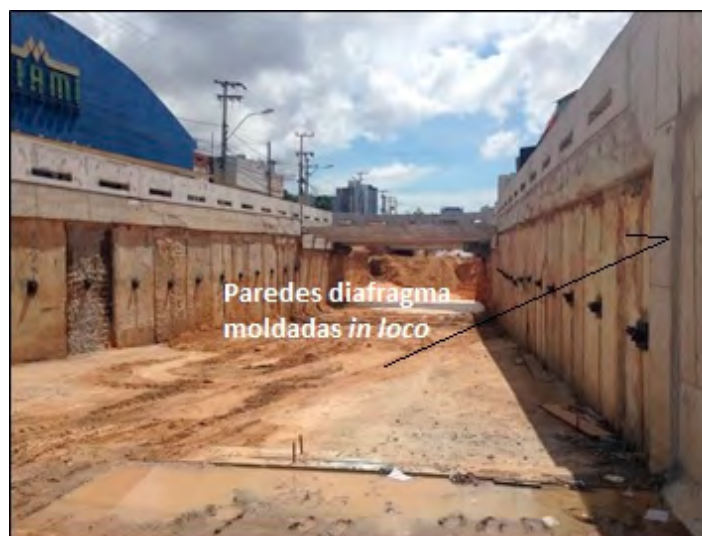
Figura 1. Vista da obra do túnel da Av. Santos Dumont
