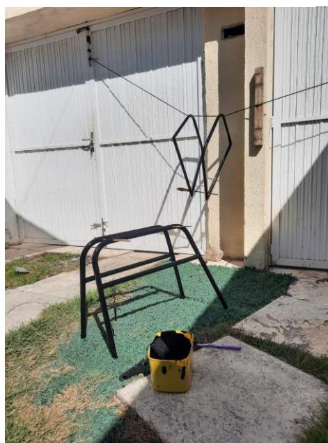
Figura 92: Etapa de pintura da estrutura metálica
