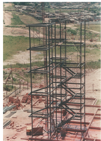
Fig. 1.10: montagem da torre de escadas metálicas no mutirão do COPROMO. Fonte: Acervo da Usina CTAH.
