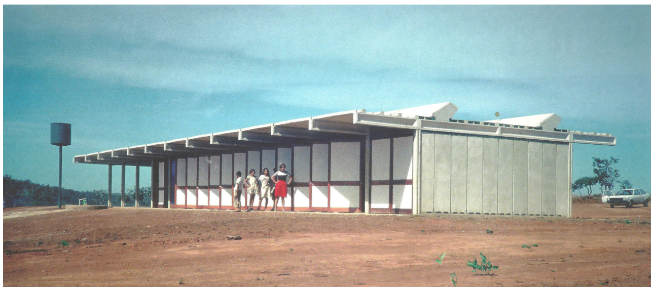
Fig. 2.1: escola transitória construída em 1984, em Abadiânia, produzida e montada dentro de 45 dias. Fonte: LATORRACA e RISSSELADA, 2010.
