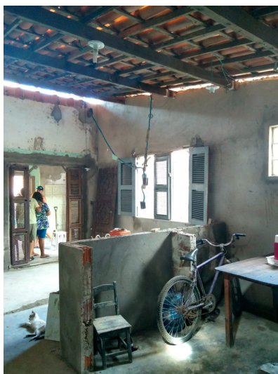
Fig. 1.1 e 1.2: reforma em casa que não tinha iluminação e ventilação naturais, no Parque Soledade, Caucaia. Para reduzir custos, as esquadrias foram compradas em galpões de usados. Fonte: acervo do autor.
