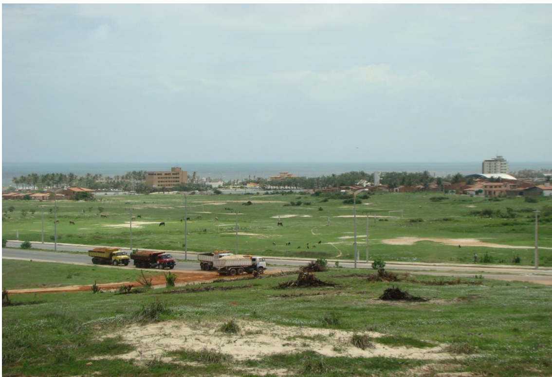
Foto 17 - Praia do Futuro. Caminhões trabalhando na construção de um condomínio de casas, ao fundo animais pastando nas dunas. Fortaleza-Ce.
