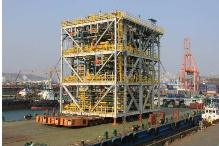
Figura 13 - Exemplo de Sistema de Remoção de CO 2 (Tupi BV Replicant Petrobras)
