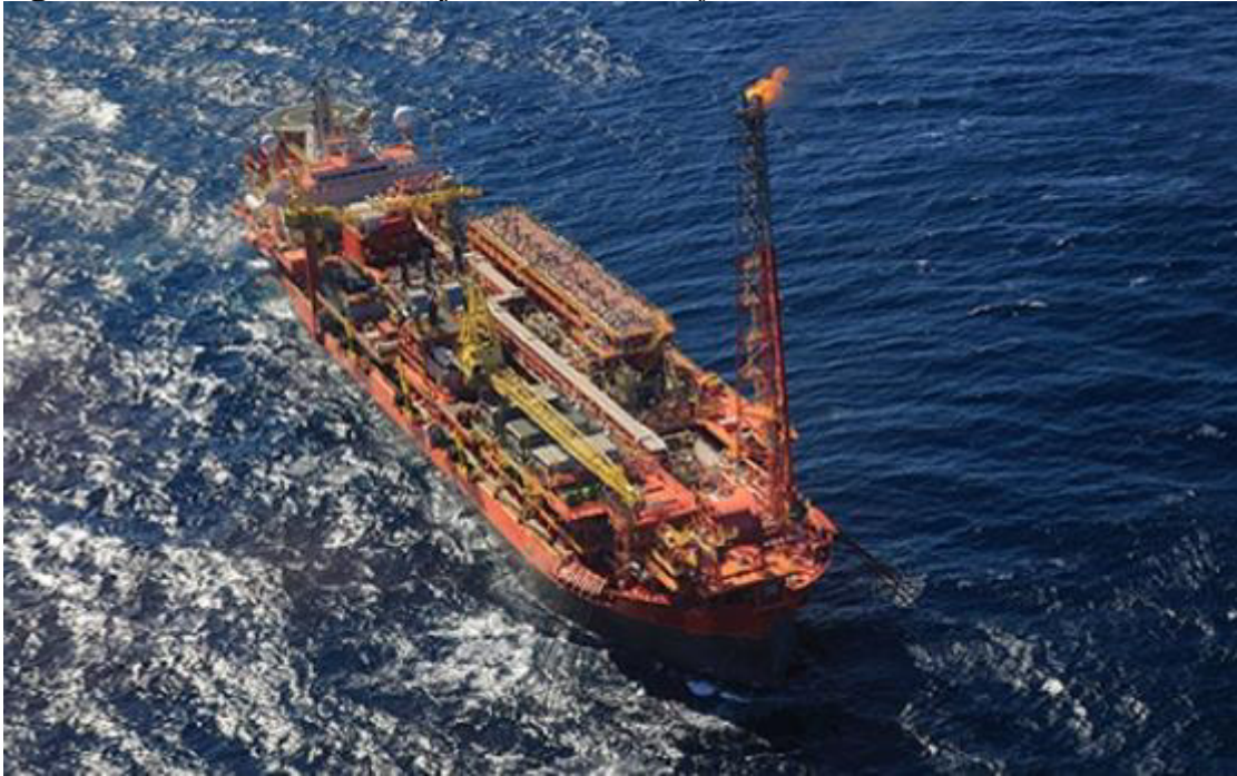
Figura 5 - FPSO Cidade de Itajaí com chama no flare
