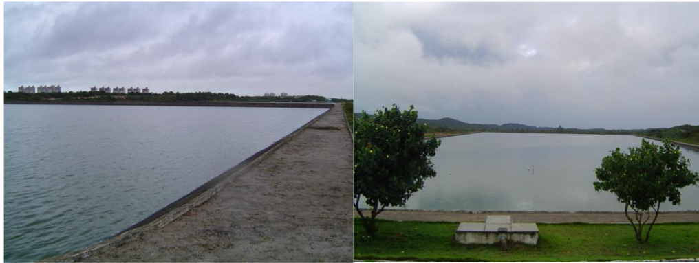
Figura 5 - ETE Ponta Negra – Lagoas de Estabilização.
