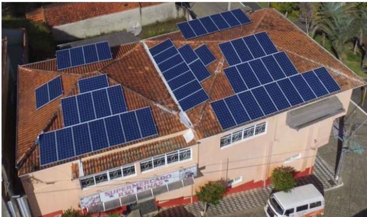
Figura 13 – Foto aérea de uma instalação fotovoltaica com módulos em várias orientações
