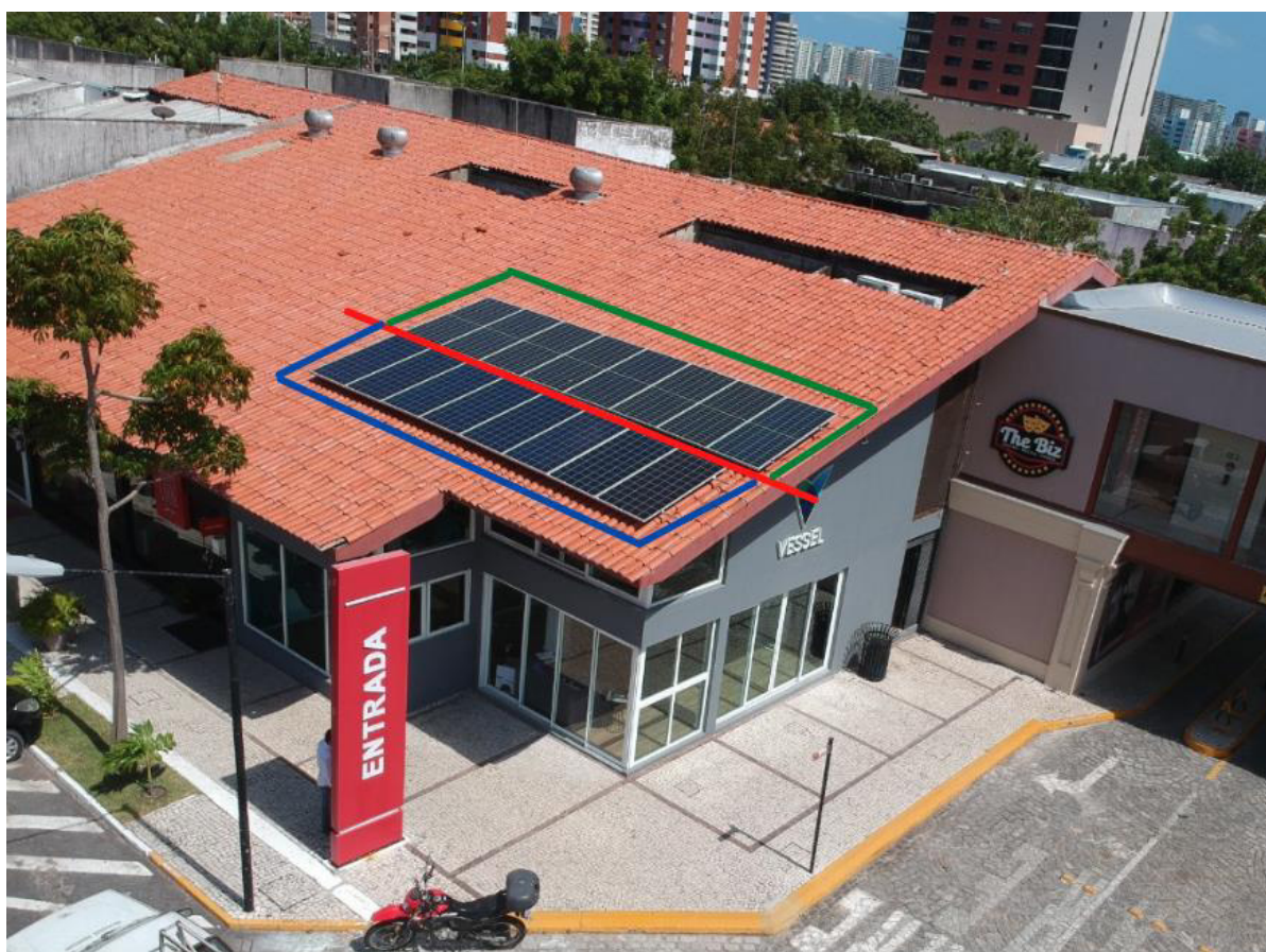
Figura 22 – Foto aérea das usinas
