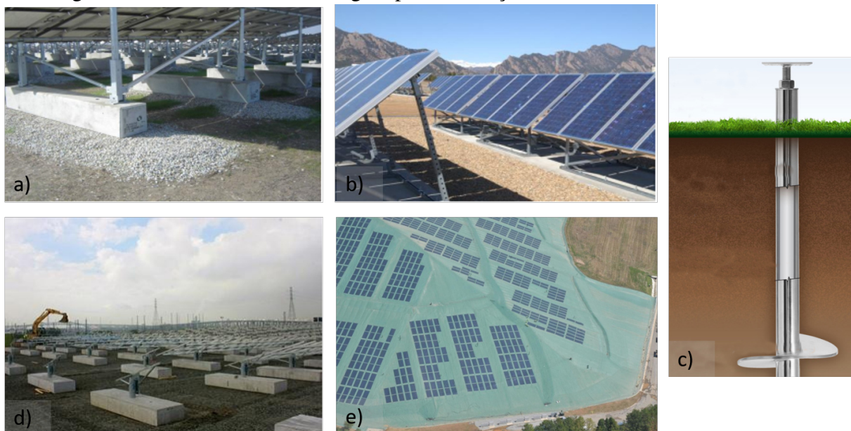
a) Base de concreto pré-fabricadas; b) Laje de concreto; c) Fundação helicoidal; d) Sistema autobalastrado e e) Geomembranas integradas a sistema FV.
