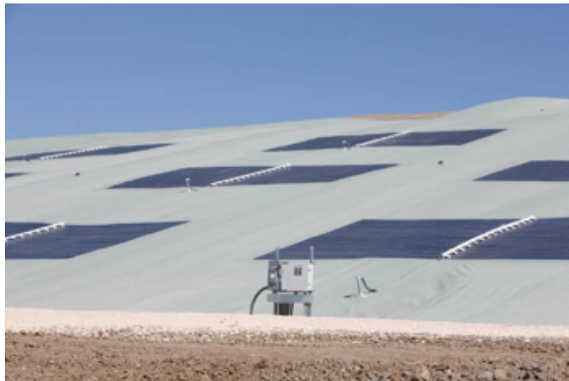
Figura 12 – Vista final do Aterro de Tessman Aterro Road
