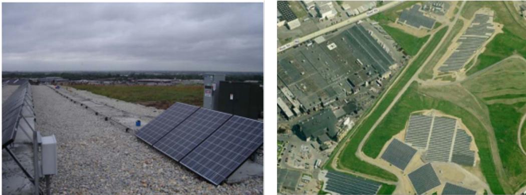
Figura 11 – Instalação de painéis solares no aterro de Pennsauken
