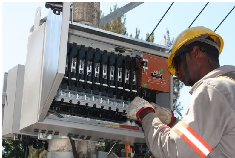
Figura 3 - Sistema de Medição Centralizada sendo instalado em um poste.
