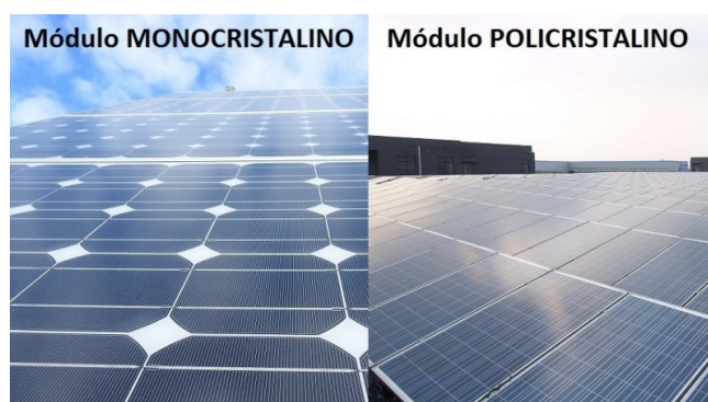
Figura 5 - Tipos de módulo fotovoltaico
