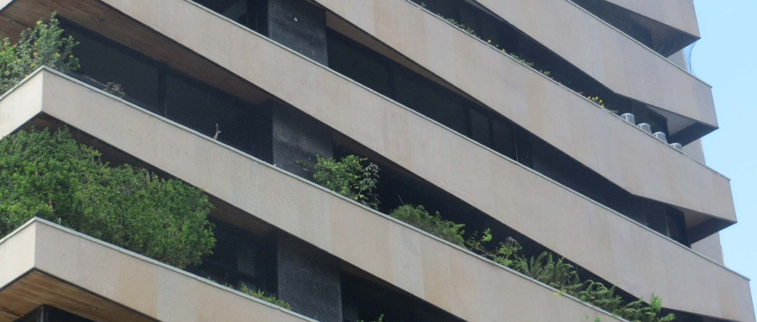
Edifício Solar da Volta da Jurema (1982) Foto_ Elton sales.
