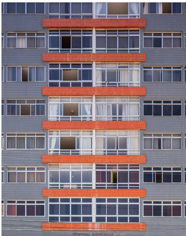
Edifício Arpoador (1970), autoria do arquiteto Rogério Froes Foto_ Igor Ribeiro.
