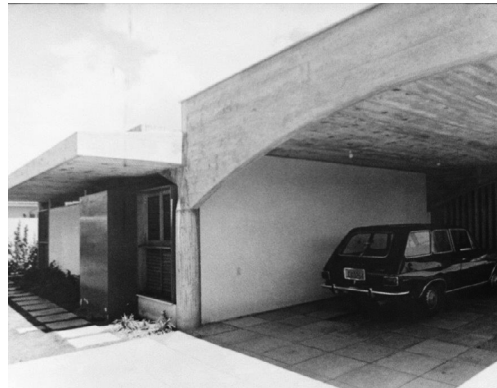
Residência de Riamburgo Ximenes (1975), de Delberg Ponce de Leon e Fausto Nilo Fonte_ Diógenes; Paiva (2013).
