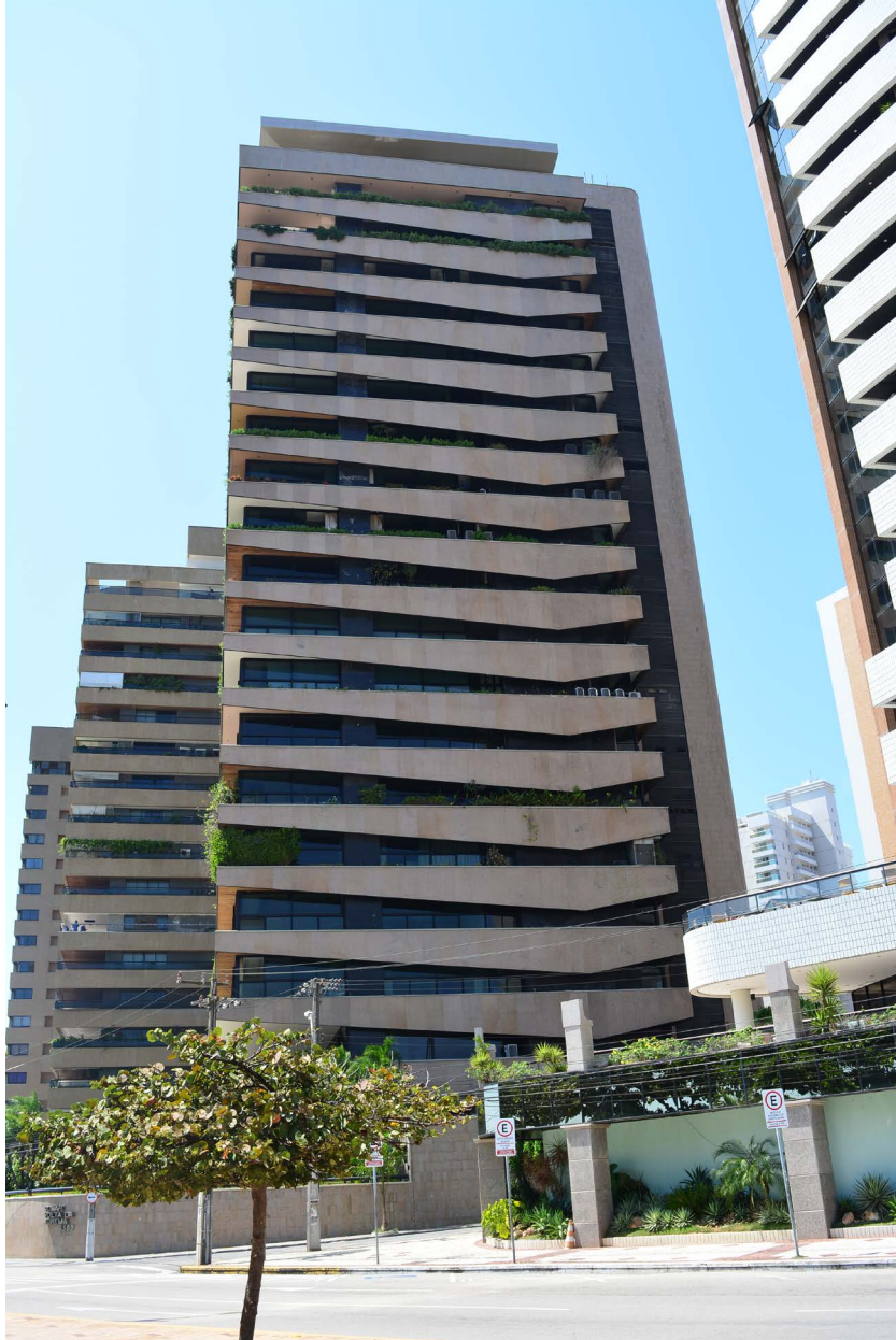
Edifício Solar da Volta da Jurema (1982) Foto_ Elton Sales.
