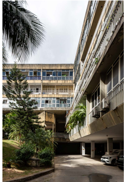
Edifício Topázio Foto_ Igor Ribeiro.
