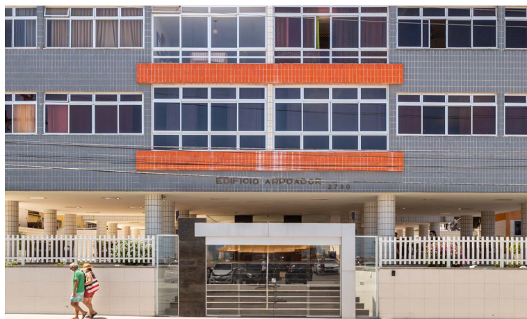
Pavimento térreo sobre subsolo integrado com a Avenida Beira- Mar Foto_ Elton Sales.
