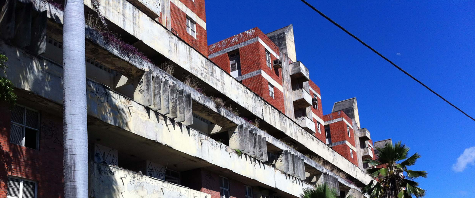
Edifício Panorama Artesanal
