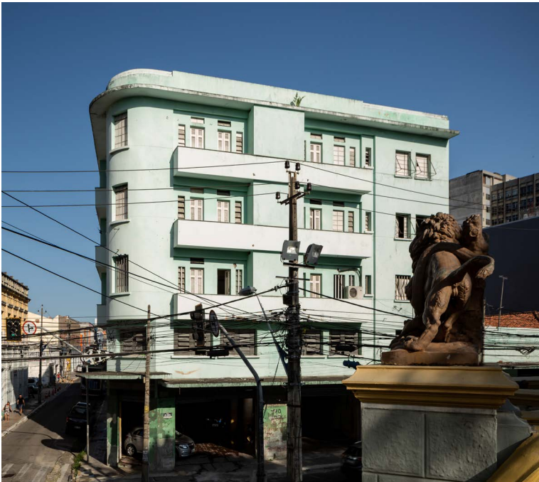
Foto atual do Edifício Carneiro (1935) Foto_ Igor Ribeiro.
