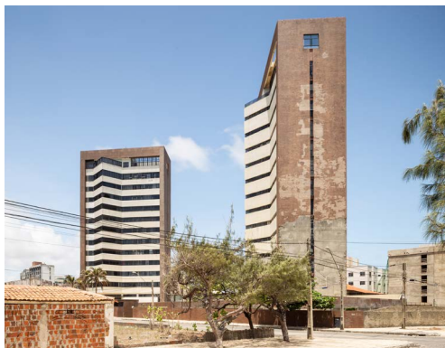
Conchas e Dunas (1986), Luiz Fiúza Arquitetos Associados Ltda e Nasser Hissa Arquitetos Associados Ltda Foto_ Igor Ribeiro.
