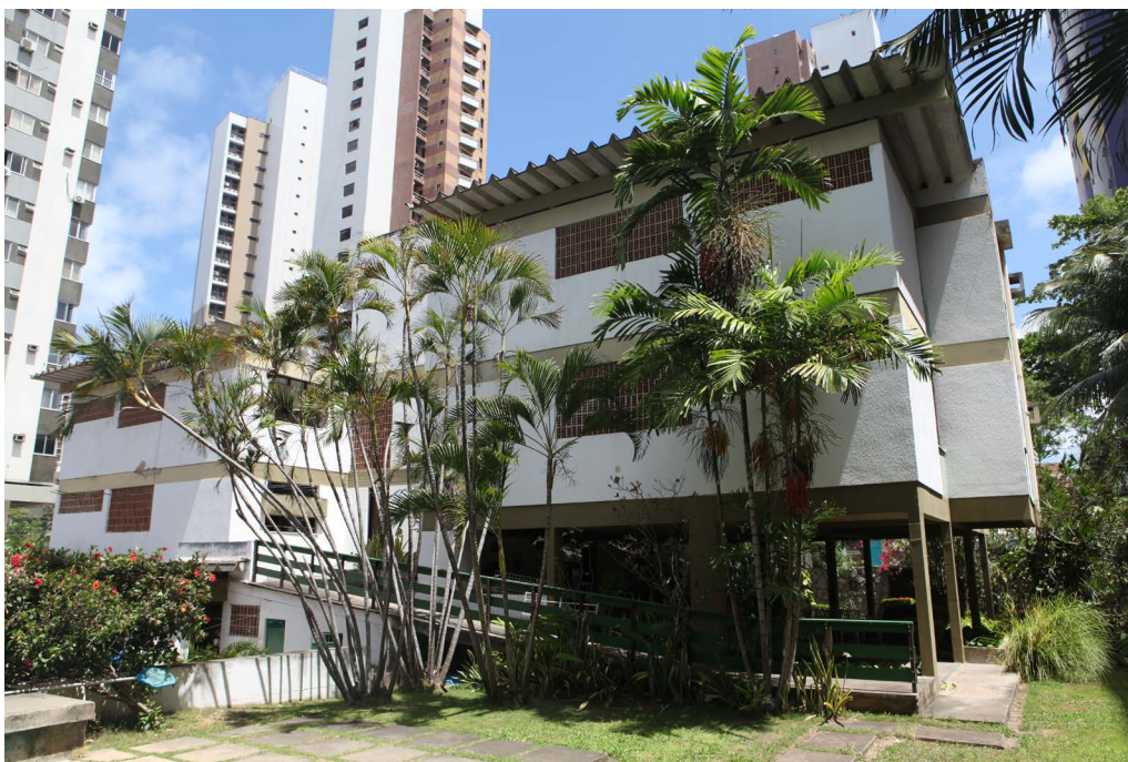
Fachada Oeste do Edifício Dr. Benício Diógenes. Observar o detalhe do fechamento dos vãos com tijolo cerâmico deitado Foto_ Ricardo Avelar.
