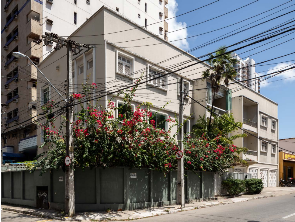
Edifício Santa Helena (1955) Foto_ Igor Ribeiro.
