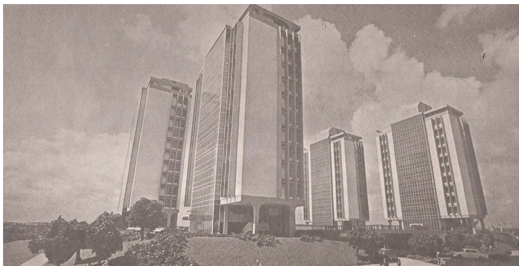
Foto original do Conjunto Residencial Palácios do Planalto Fonte_ Cadernos Brasileiros de Arquitetura, Panorama da Arquitetura Cearense, volume I, p. 34
