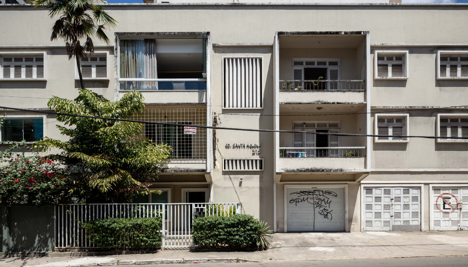
Edifício Santa Helena (1955) Foto_ Igor Ribeiro.
