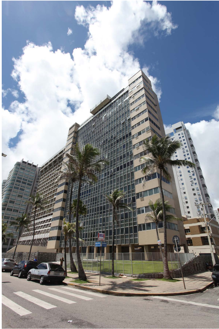
Fachada do Edifício Dom Pedro I (1975) Foto_ Ricardo Avelar.
