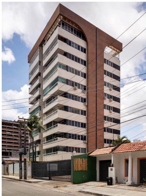
Edifício Bonini (1980), arquitetos Ione Fiúza e Luíz Barbosa Fiúza Foto_ Igor Ribeiro.
