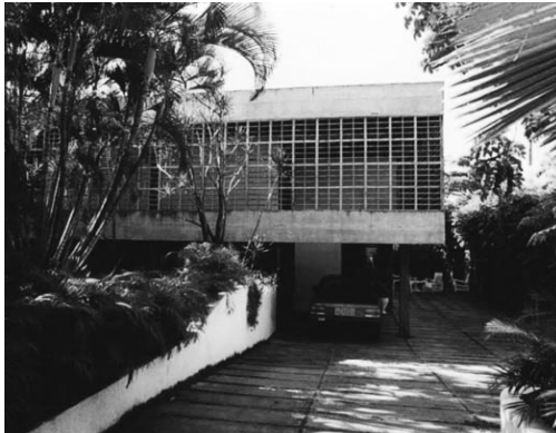
Residência de Francisco Alcides Germano (1975), de Roberto Castelo e José da Rocha Furtado Filho Fonte_ Jucá (2011).
