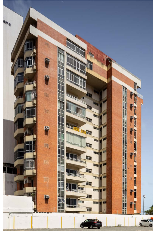
Edifício Morada Vento Leste (1976) Foto_ Igor Ribeiro.
