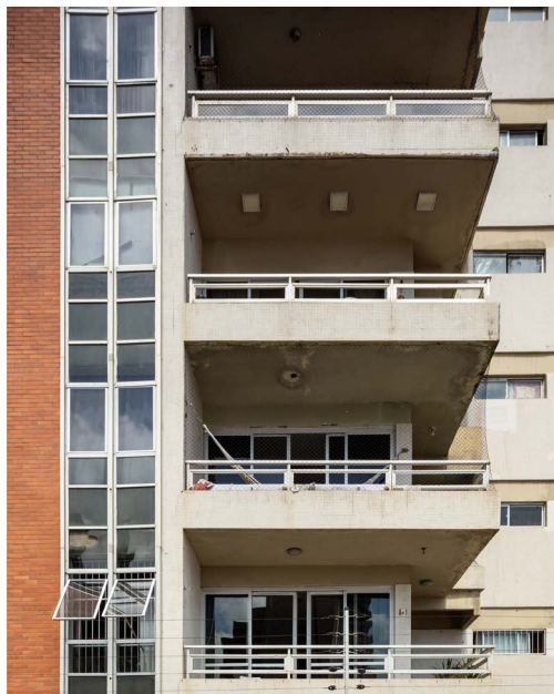
Edifício Morada Vento Leste (1976) Foto_ Igor Ribeiro.
