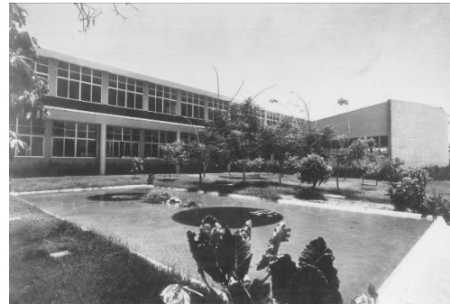
Sede do Departamento Autônomo de Estradas de Rodagem -DAER, atualmente Procuradoria Geral de Justiça do Ministério Público (1962), autoria de José Armando Farias Fonte_ Diógenes (2014).
