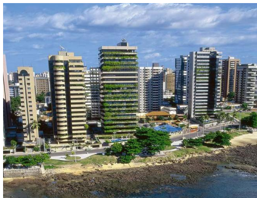
Edifício Solar da Volta da Jurema, vista do mar Fonte_ www.skyscrapercity.com . Visita: 05 setembro 2015.
