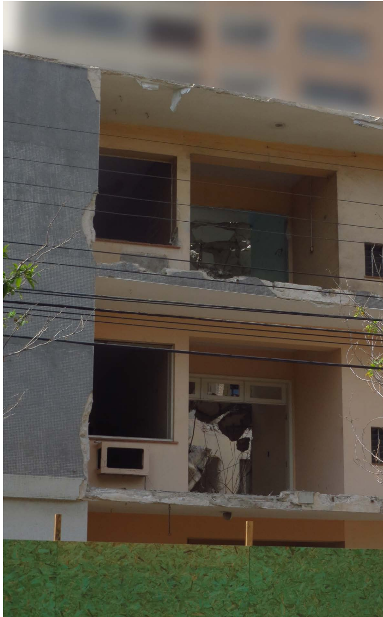
Registro da demolição ocorrida em fevereiro de 2014 Foto_ Acervo da autora.
