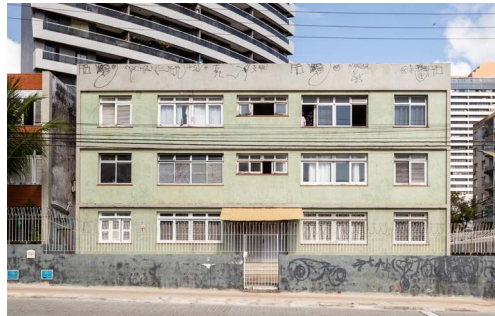
Edifício Lúcia Foto_ Igor Ribeiro.
