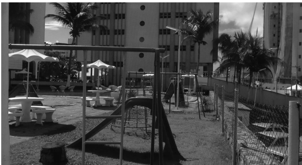
Área de lazer do Conjunto Residencial Palácios do Planalto (1979), arquitetos Delberg Ponce de Leon e Fausto Nilo Costa Junior
