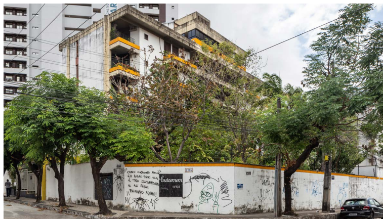
Edifício Curumim (1980) Foto_ Igor Ribeiro.
