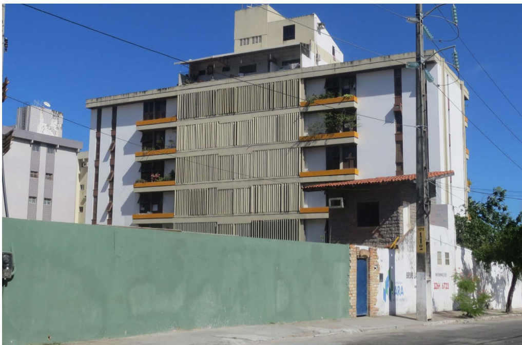
Detalhe da platibanda sacando e gerando sombra na fachada norte do Edifício Curumim
