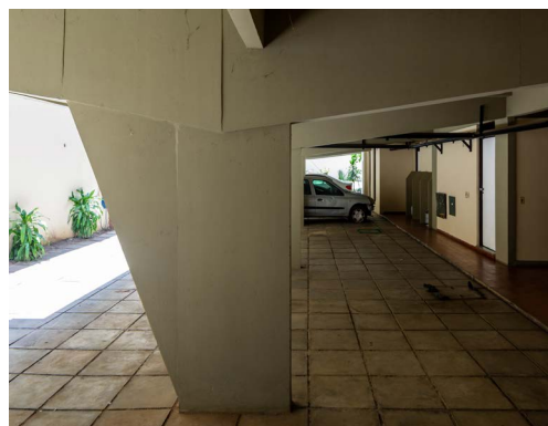
Pilares em formato de “V” no subsolo Foto_ Igor Ribeiro.
