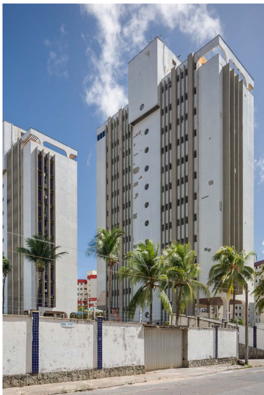
Fachada oeste do Conjunto Residencial Palácios do Planalto (1979) Foto_ Igor Ribeiro.
