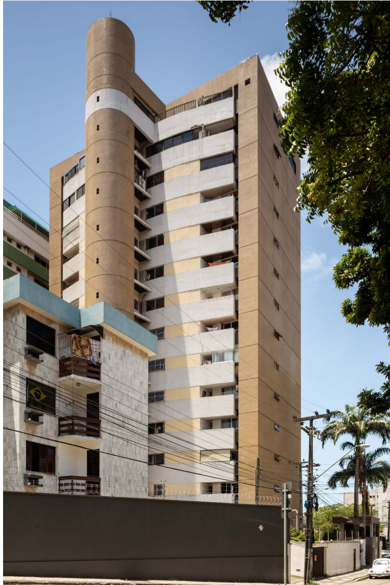
Edifício Firenze Foto_ Igor Ribeiro.
