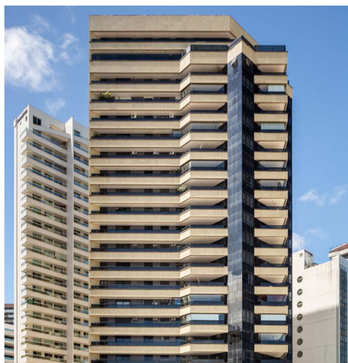
Edifício Veneza IV (1985), arquitetos José Nasser Hissa e Francisco Nasser Hissa Foto_ Igor Ribeiro.
