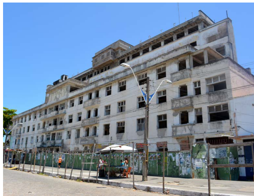
Edifício Philomeno Gomes e Lord Hotel (1956) Foto_ Elton Sales.
