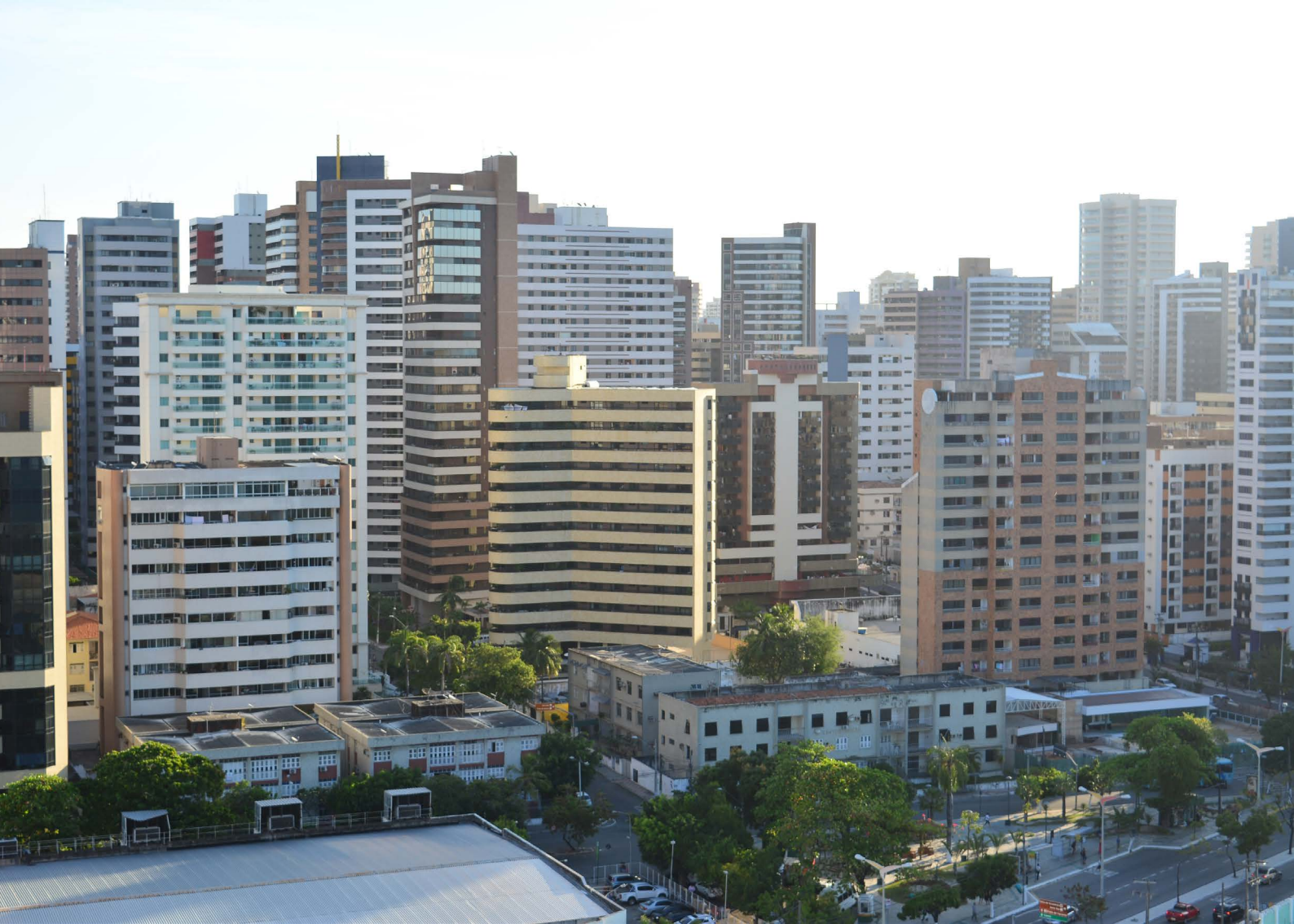
Contexto urbano da esquina das Avenidas Desembargador Moreira com Abolição Foto_Elton Sales.
