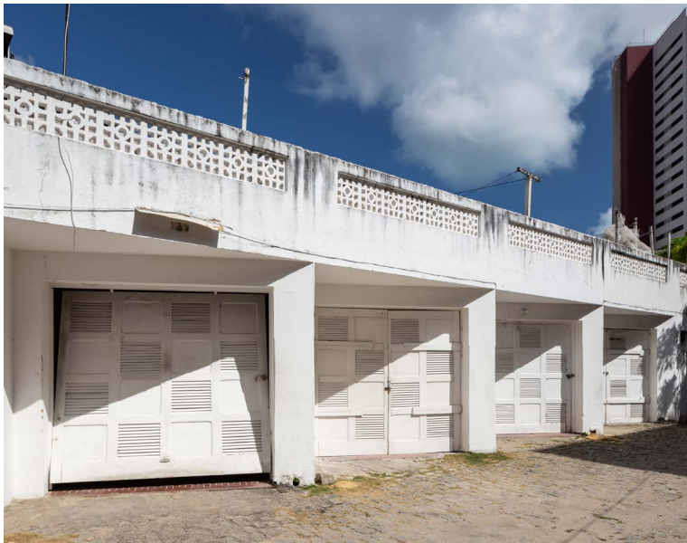
Garagens independentes do Edifício Santos Dumont Foto_ Igor Ribeiro.
