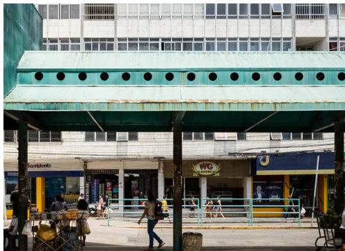
Esquadria - detalhe da fachada do Edifício Paraguassú Foto_ Igor Ribeiro.
