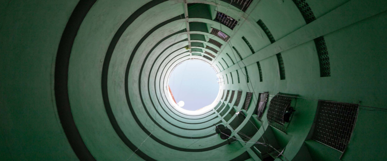
Poço de ventilação do Edifício Palácio Senador Foto_ Igor Ribeiro.
