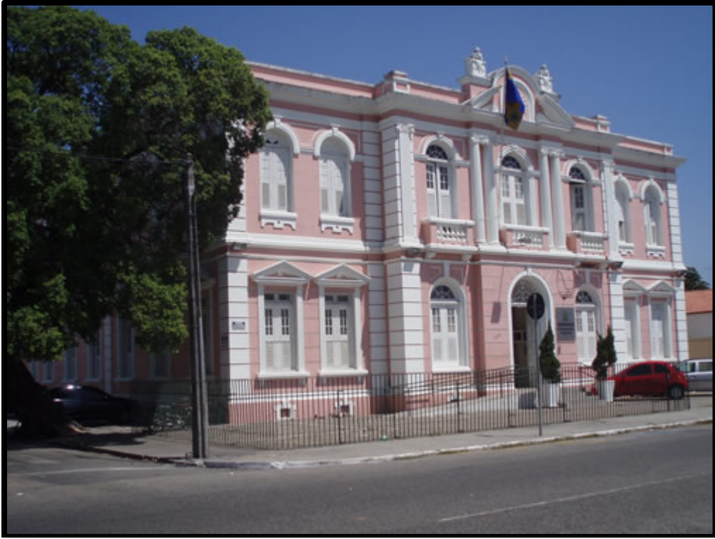
Figura 3 – Fachada da Unidade Acadêmica FEAAC – UFC
