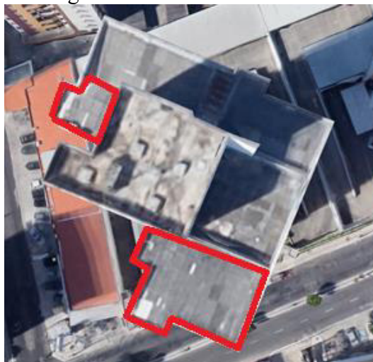
Figura 9 - Telhado da cobertura
