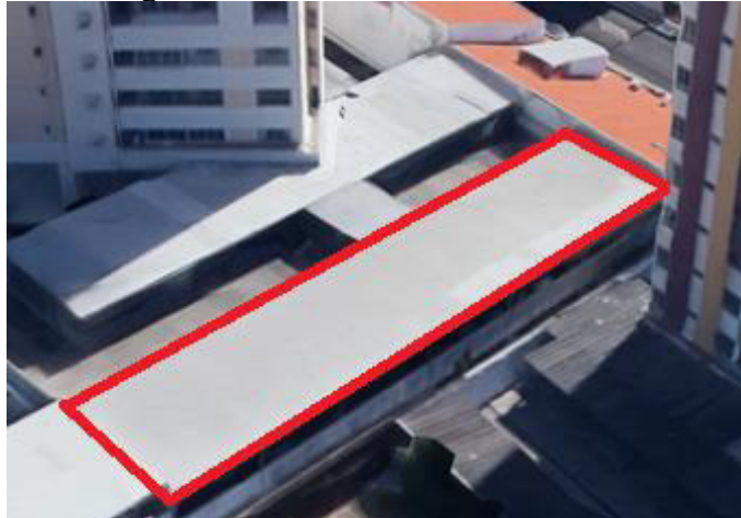
Figura 8 - Telhado do Estacionamento
