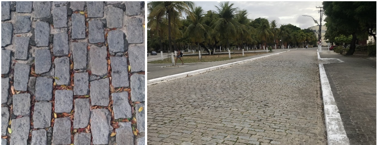
Figura 52 - (a) Rua interna do Campus do PICI/UFC com (b) pavimento paralelepípedo.
