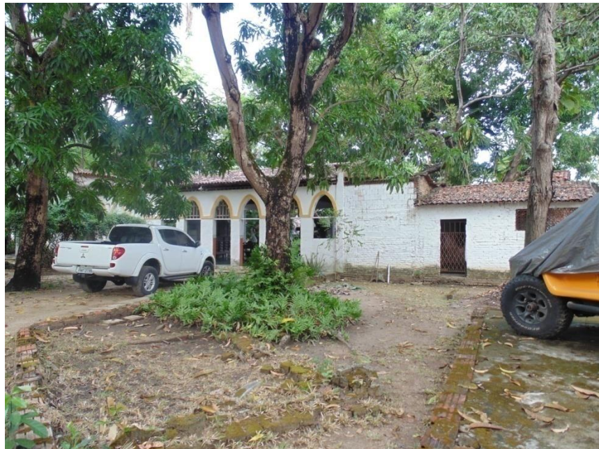
Figura 3 – Construção localizada logo no início da área da RPPN Monte Alegre.
