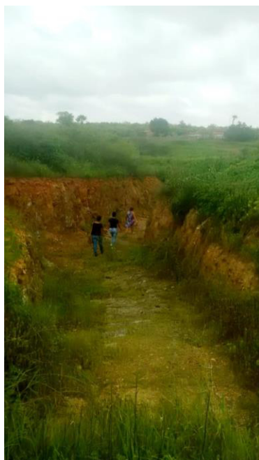
Figura 15. Barreiro trincheira em desuso devido construção em local inadequado.
