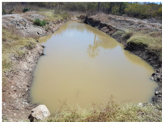
Figura 8. Barreiro trincheira no Assentamento.
