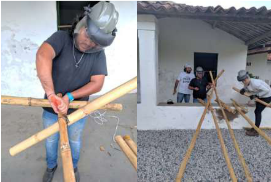
Figura 7: Montagem dos poleiros.
