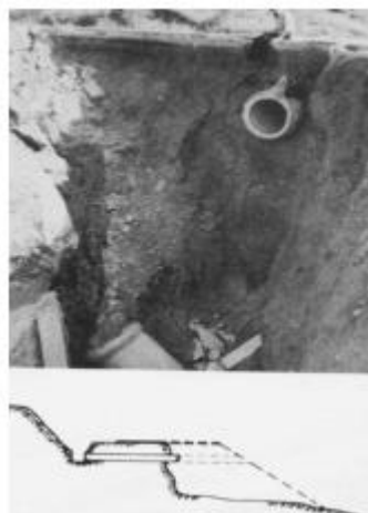
Figura 6: Erosão causada por falha na linha de drenagem.
