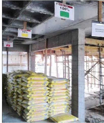
Figura 3 – Controle visual dos níveis de estoque na Obra D. Fonte: Autores (2017).
