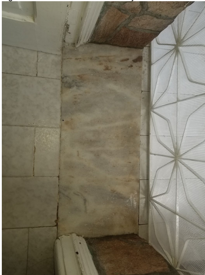
Figura 27 - Soleira Entrada de Serviço
