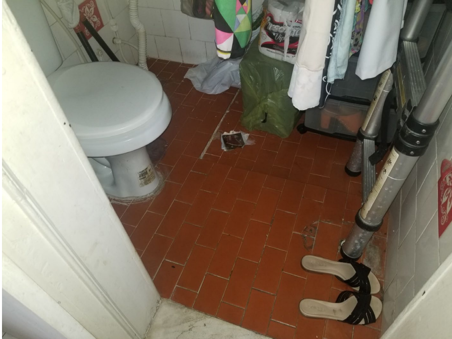
Figura 32 - Banheiro da Suíte
