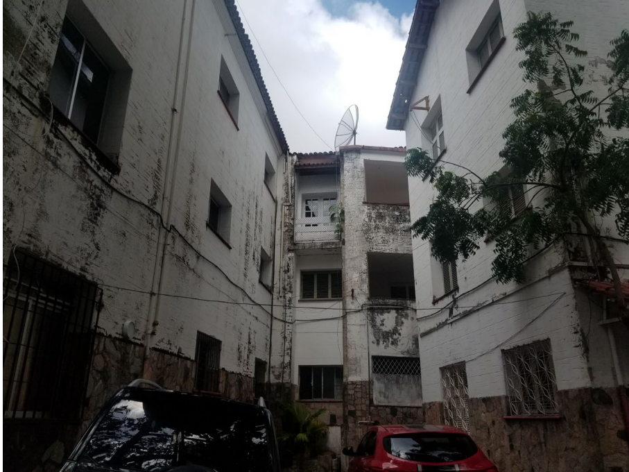
Figura 38 - Entrada Escada de Serviço Bloco C
