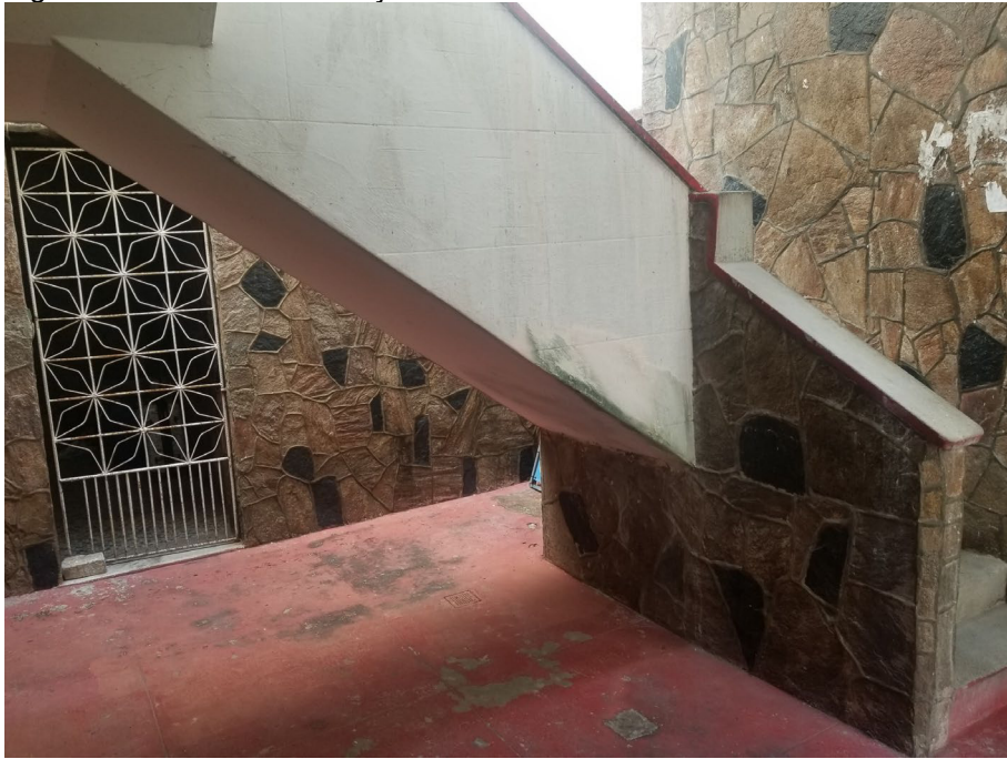
Figura 42 - Escada de Serviço
