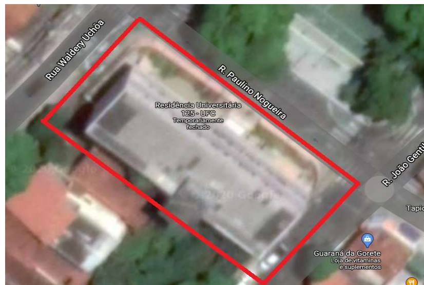
Figura 5: Imagem superior do prédio da inspeção
