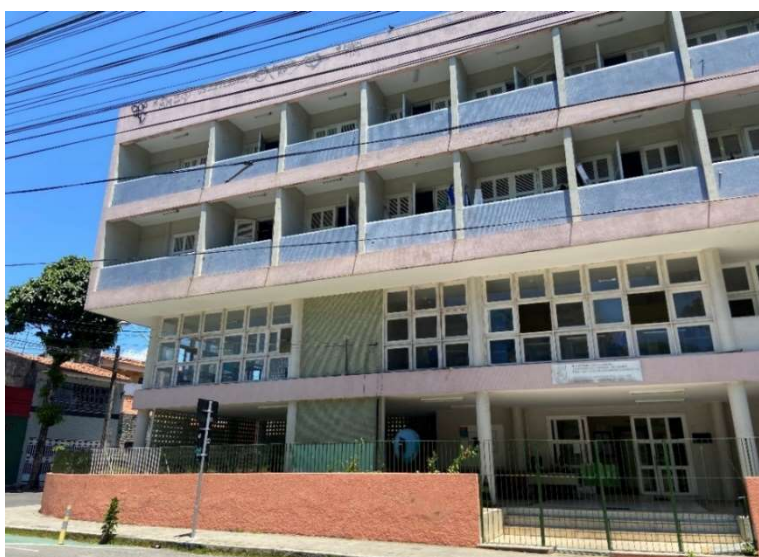
Figura 3: Fachada do prédio da inspeção
