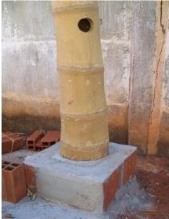
Figura 27 – Fundação com Bambu .
