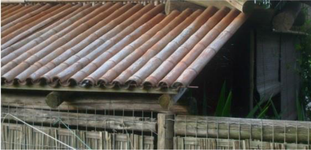
Figura 31 – Telha de bambu.
