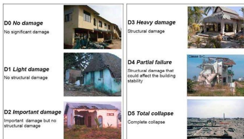
**Figura 23:** Exemplos de danos em edifícios, associados à matriz de danos proposta na Tabela 6. As fotos são do tsunami de 2004 no Oceano Índico (fontes: Leone et al. 2010, Perirs 2006 e Garcin et al. 2007)
