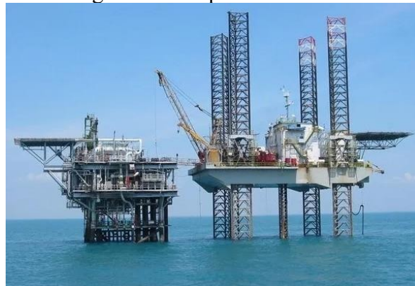
Figura 2 - Imagem de uma plataforma auto-elevatória
