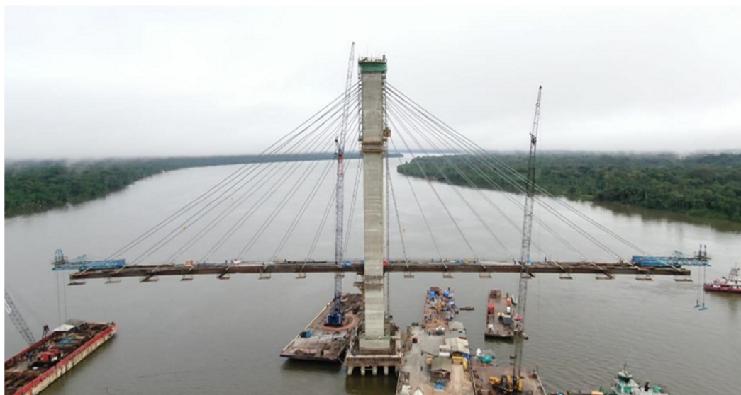
Figura 1 – Fase de execução da ponte do Moju.
