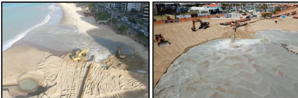
Figura 4 – Procedimento de engorda da Praia de Iracema em outubro de 2019
