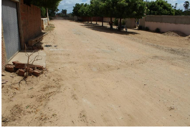
Figura 23 - Canal aberto por morador na seção da estrada.
