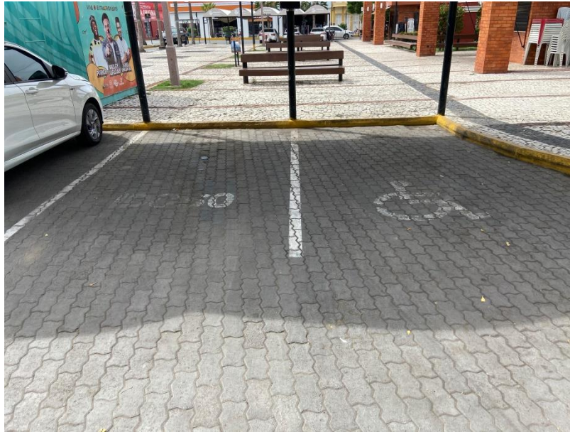
Figura 110 – Sinalização apagada das vagas
