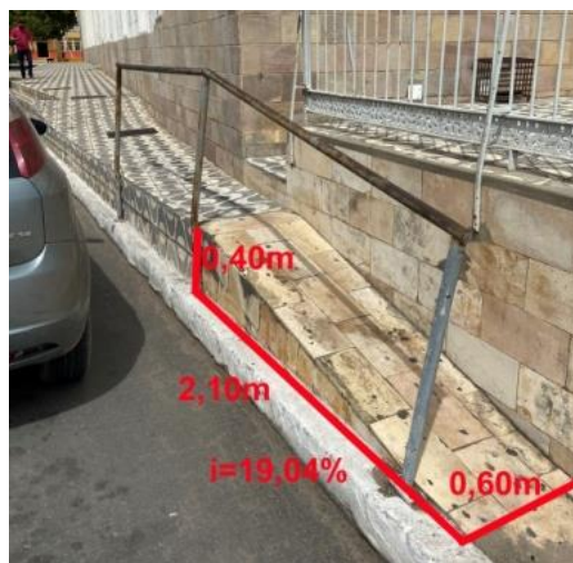
Figura 103 – Rampa frontal lateral esquerda da igreja.
