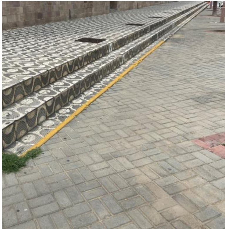
Figura 89 – Piso da Praça Monsenhor João Luiz (Bloco intertravado de concreto e Piso hidráulico branco)
