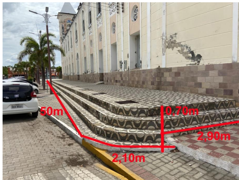
Figura 98 – Trecho final da escada lateral direita.
