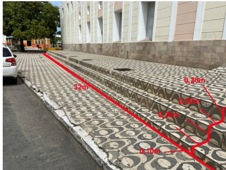
Figura 99 – Escada lateral esquerda da igreja
