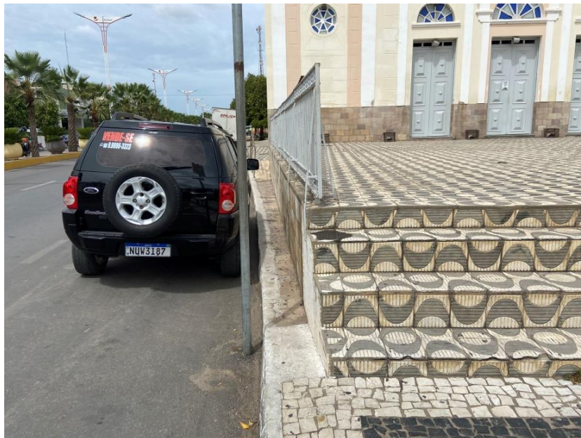
Figura 88 – Calçada fora dos padrões mínimos
