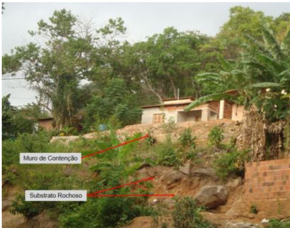
**Figura 11** – Construção, de segunda residência, em encosta íngreme com significativos cortes na vertente centro oriental do maciço de Maranguape-Ceará.
