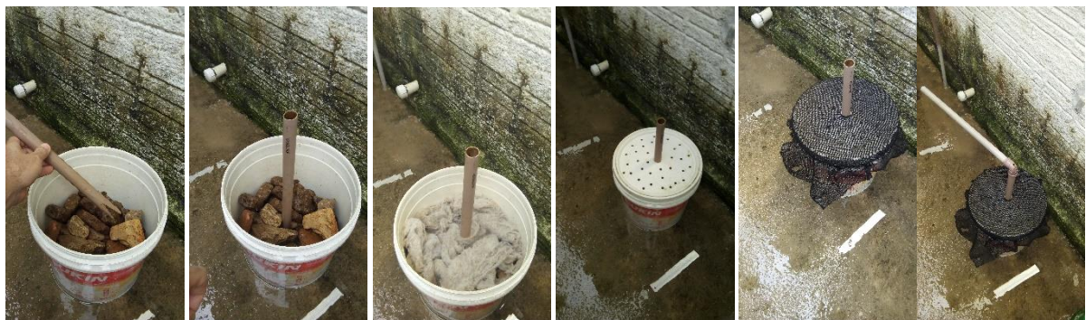
Figura 7 - Sequência de montagem de um FAI
