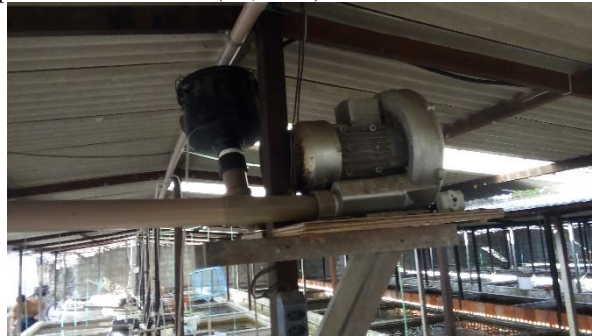
Figura 6 - Soprador marca Asten (~1,7 CV) com filtro e tubo em PVC de 50mm
