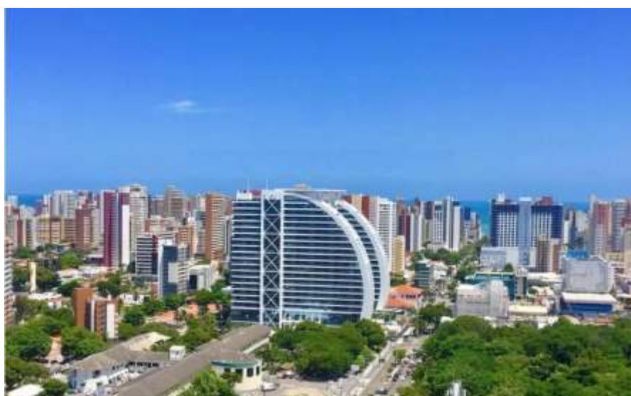
Figura 30 - Vista das Torres do BS Design, no primeiro plano Hospital do Exército (à esquerda) e Praça das Flores (à esquerda).
