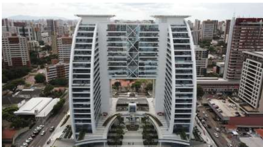
Figura 29 - Prédio BS Design na Avenida Desembargador Moreira.
