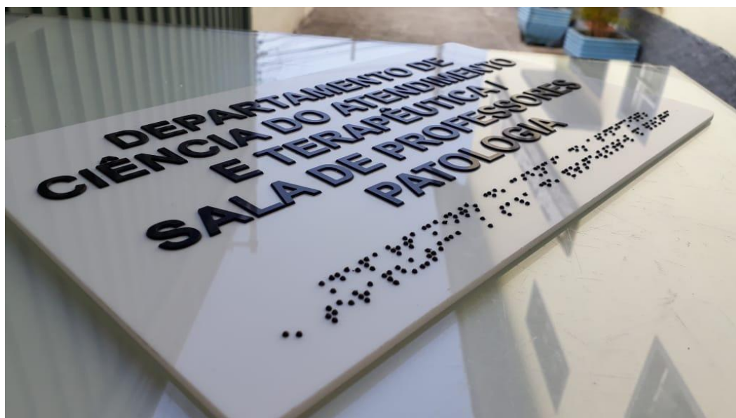
Figura 12 — Detalhe de uma placa tátil em caixa alta 13 .
