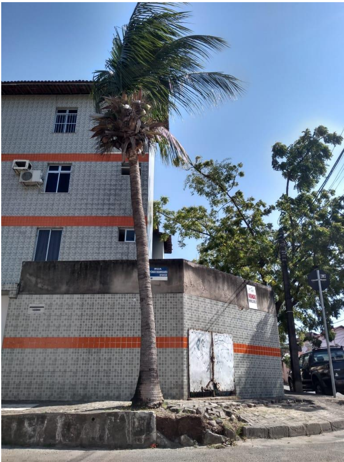
Figura 13: Avaliação de árvore comprometendo as instalações. Fonte: Miller Clementino (2020)
