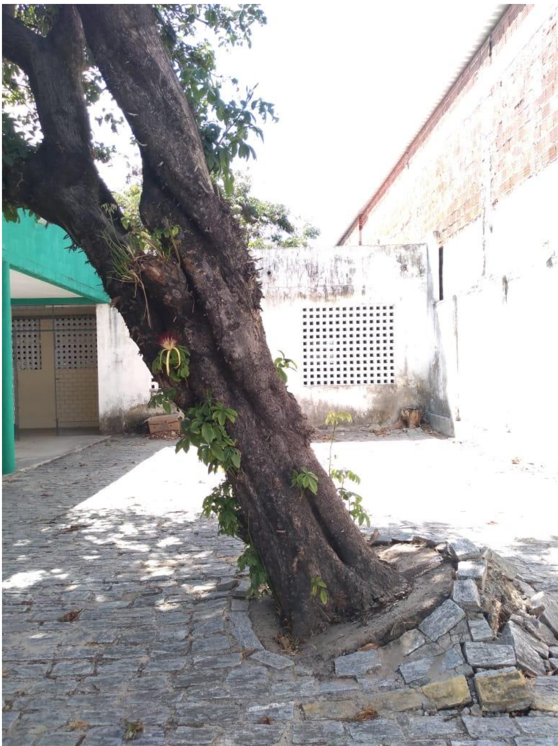
Figura 12: Avaliação de árvore comprometendo as instalações. Fonte: Sara Cardoso (2020)
