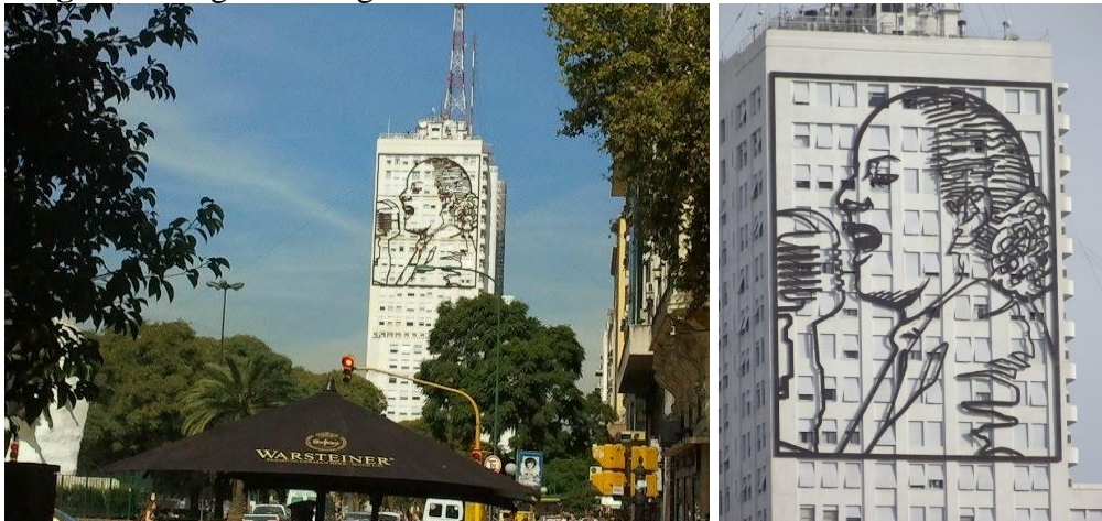
Figura 1: Registro fotográfico do Edifício do Ministério das Obras Públicas.
