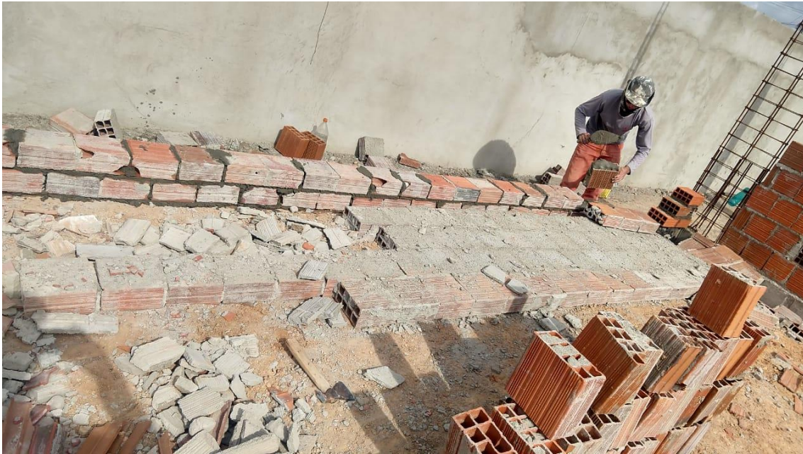
Figura 10 – Reexecução de alvenaria de vedação
