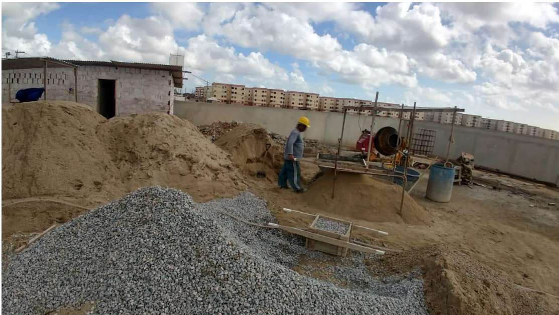
Figura 9 – Produção de concreto realizada de modo bastante manual.
