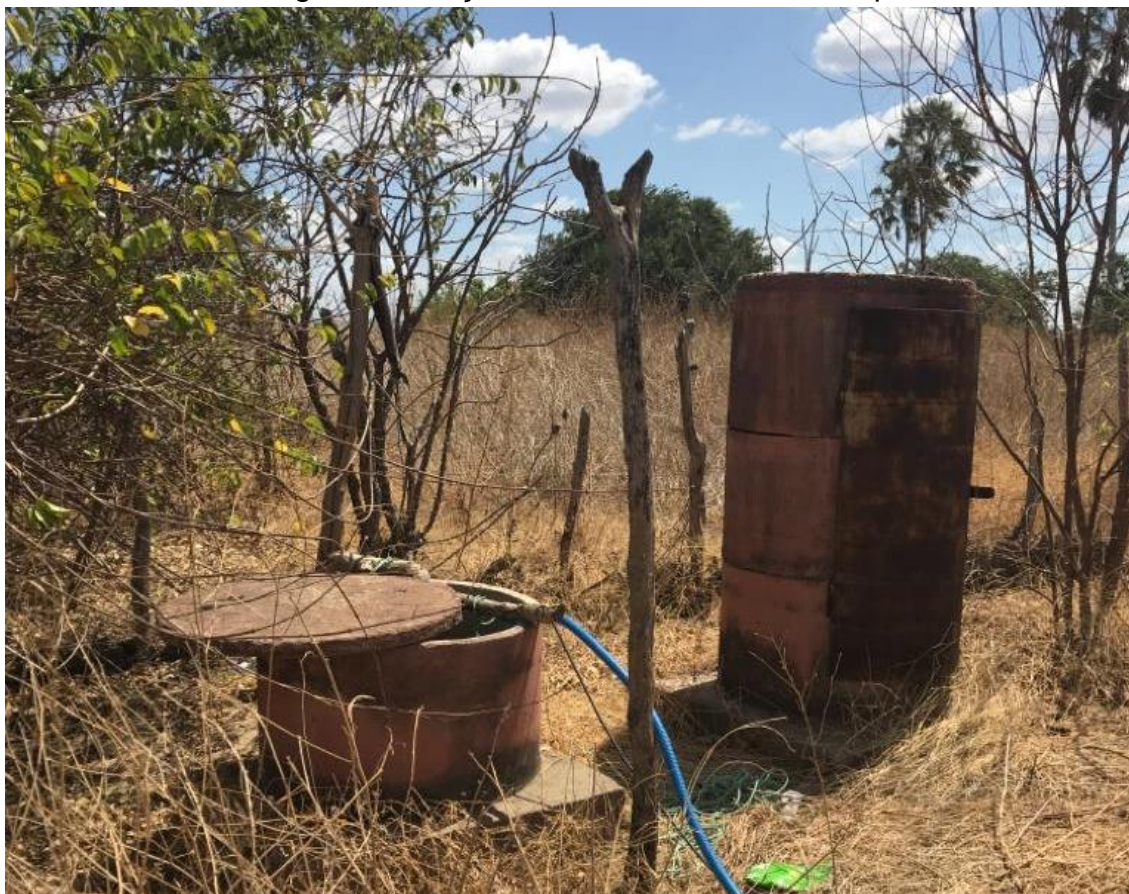
Figura 1 – Poço I01, na localidade de Campos.
