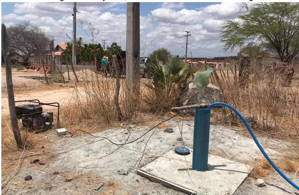
Figura 5 - Poço I22, na localidade de Riacho do Sangue.
