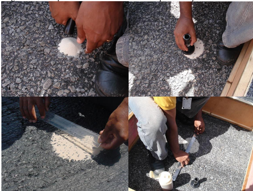
Figura 4 – Execução do ensaio de mancha de areia para obtenção de macrotextura
