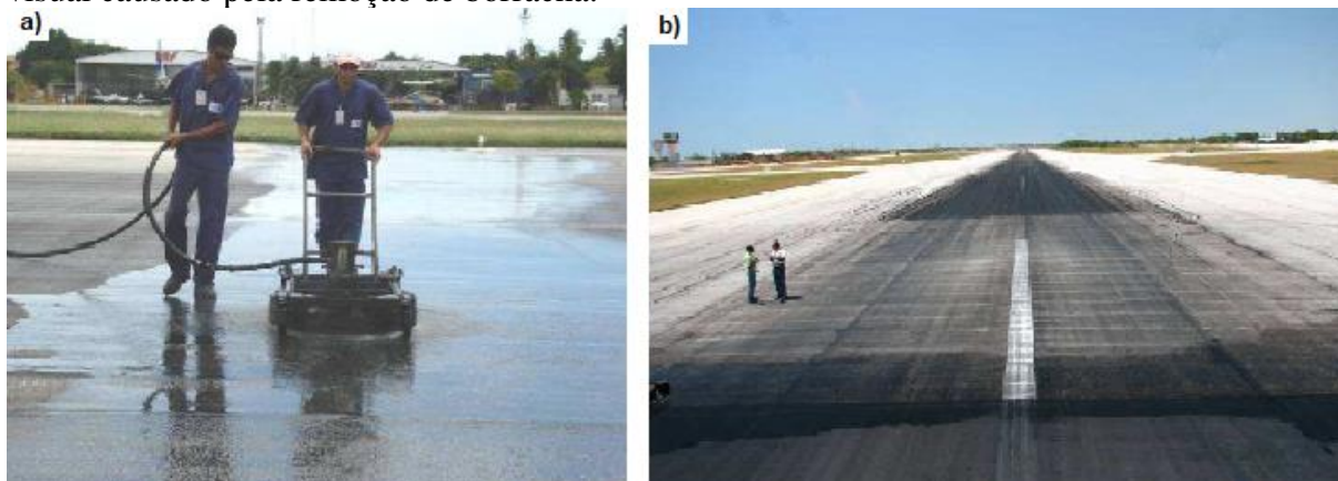
Figura 5 – (a) Serviços de remoção de borracha com jato de água de alta pressão e (b) efeito visual causado pela remoção de borracha.
