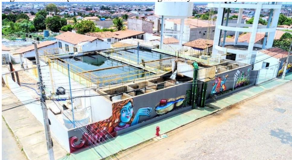
Figura 19 – Estação de Tratamento de Água Poty – ETA Poty
