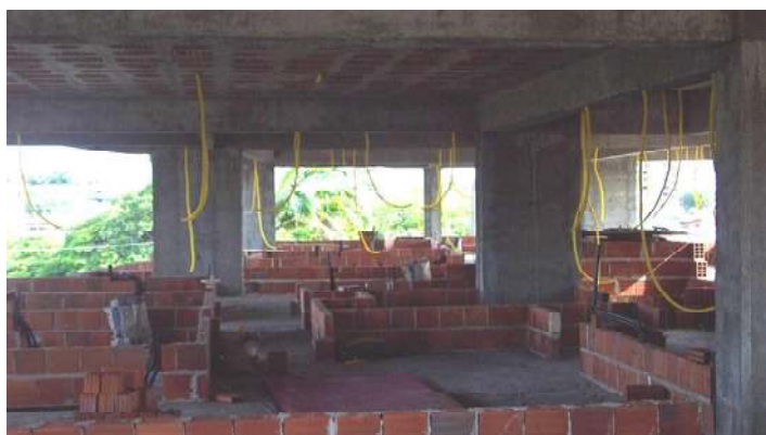
Figura 1 – Pacote de marcação de alvenarias
