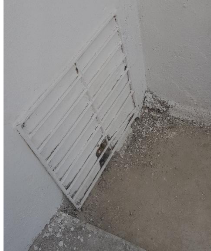
Figura 17 - Local de escoamento de águas pluviais para fora da edificação
