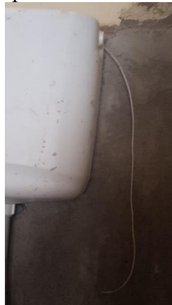
Figura 20 - Caixa de descarga sem puxador
