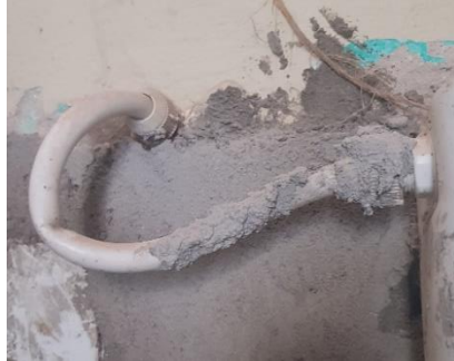
Figura 19 - Flexível com concreto endurecido
