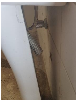
Figura 25 - Sifão desconectado
