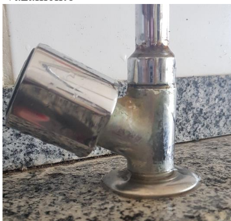
Figura 30 - Torneira com vazamento
