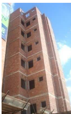
Figura 1. Edifício de oito pavimentos em alvenaria estrutural em execução na cidade de Fortaleza. MEHIS.
