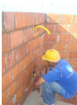
Figura 3. Eletrodutos e caixas elétricas assentadas em paralelo à elevação da alvenaria.
