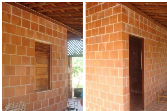
Figura 4. Vergas e contra-vergas que utilizam os próprios blocos cerâmicos na elevação da alvenaria.
