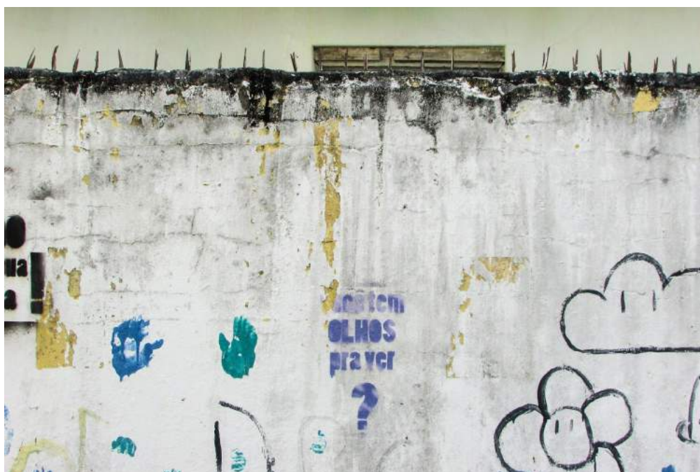
Figura 27 - Muro Interno Centro de Humanidades 1
