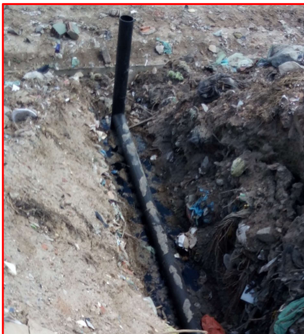
Figura 5. Vista do tubo de PEAD de 160mm utilizado como dreno
