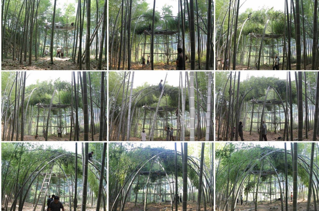
Figura 16 – Registros do processo de construção da abóbada tecida com bambu.
