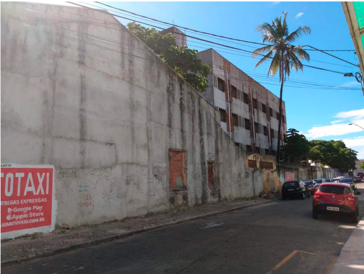
Figura 94: Lateral do terreno escolhido e travessa Quixadá
