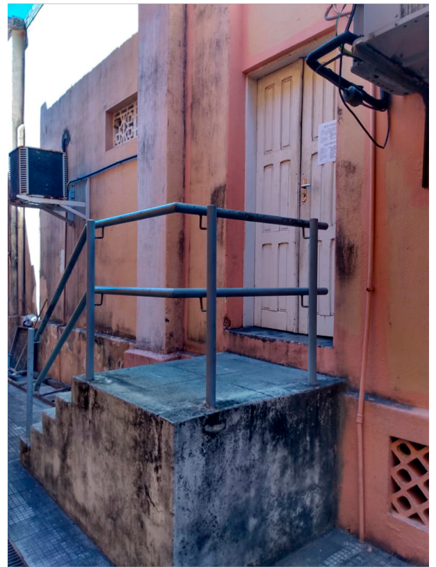
Figura 51: Escada de acesso ao palto pela parte externa
