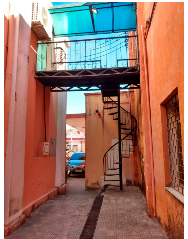
Figura 52: Escada de acesso à cabine de luz e som
