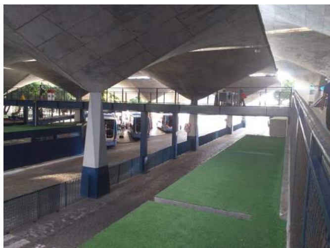
Imagem 36 e 37 Nessas duas imagens são vistas as novas rampas incorporadas para aumentar o pé direito livre para os ônibus
