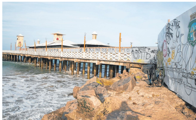
FIGURA 10 - Reforma da Ponte dos Ingleses
